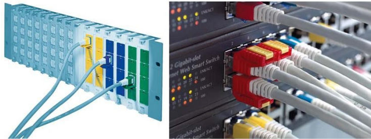
Gambar 18 Pewarnaan pada Cable Jackets
